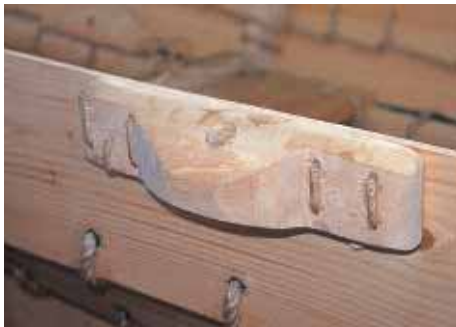
外側より 写真129
