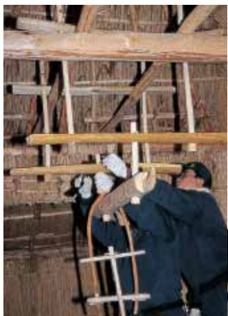
炉棚をつくる
