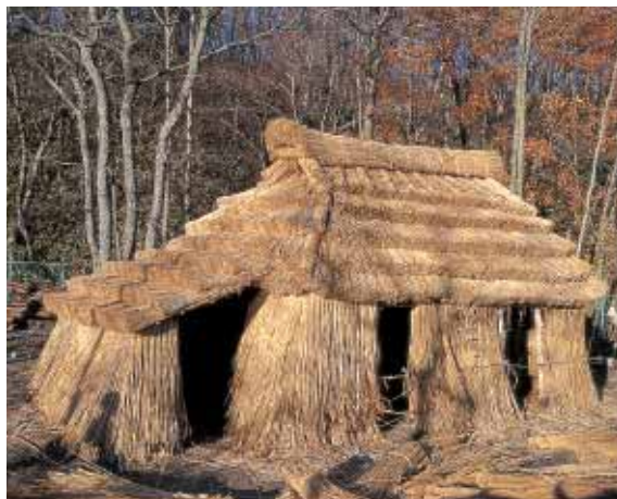
入口や窓の部分は空けておく
