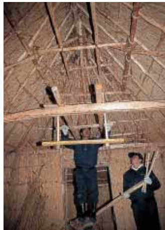
炉棚をつくる
