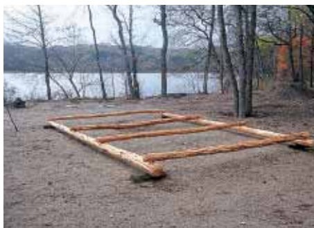
桁と梁を置く
