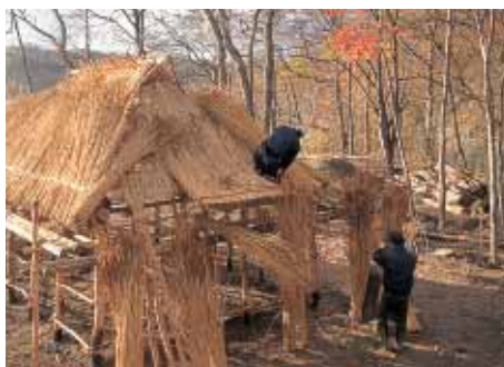
足場をつくる
