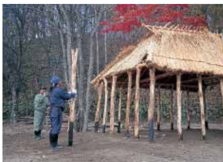
隅柱を立てる
