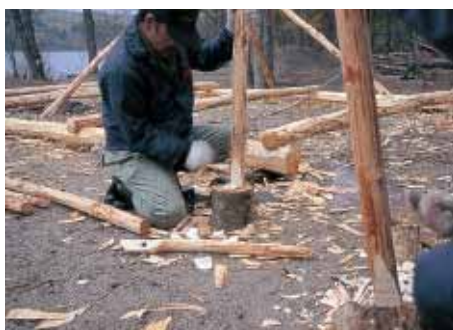
元口の端を扁平に削り、先をとがらす
