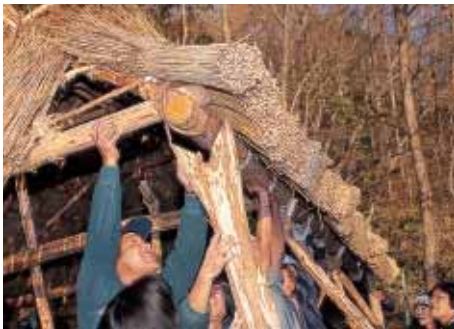
屋根を隅柱に乗せる
