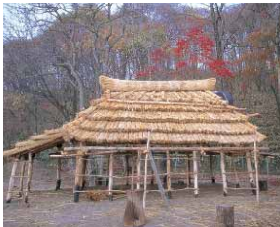
完成した棟茅
