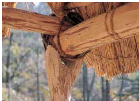
隅柱と桁の接合部
