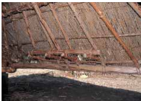
屋根内側の庇
