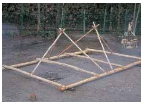
完成した三脚を桁・梁に乗せてみる
