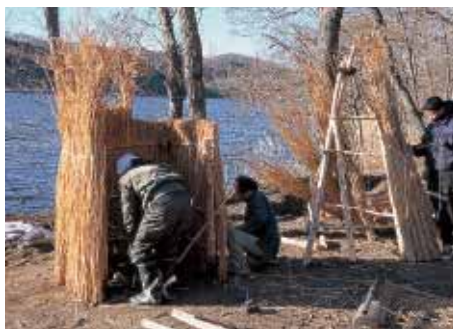
便所をつくる
