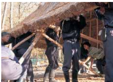
片側を上げ、土台を置く
