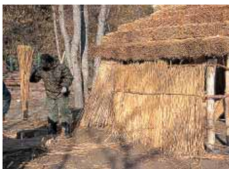
モセムの壁を葺く
