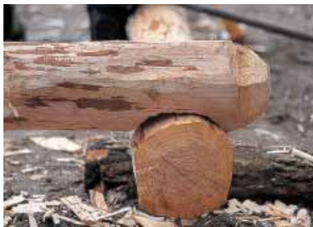
桁と梁の交差
