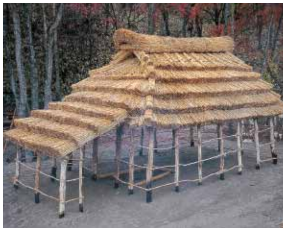
完成した屋根
