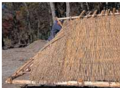
屋根すだれ、隅の部分
