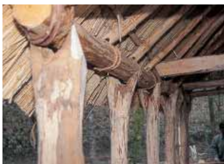
間柱と桁の接合部
