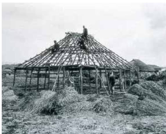
柱を立て、その上で組み立てる
