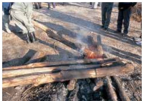
柱材で地中に埋まる部分を焼く
